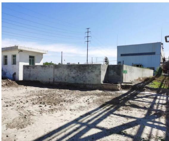
依托已建事故池
